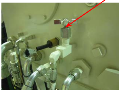
Рис 2: кран гидробака : закрыт
